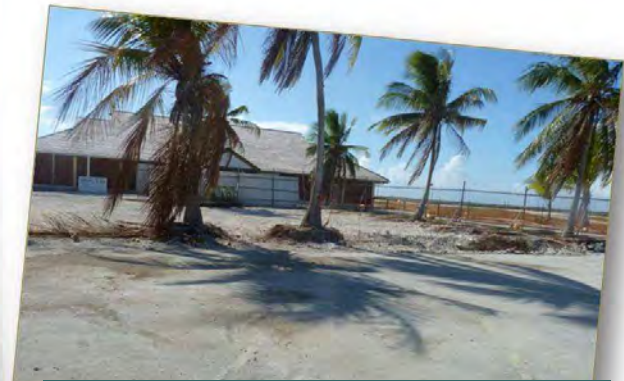
L'emplacement de l'ancienne aérogare à l'issue des travaux
