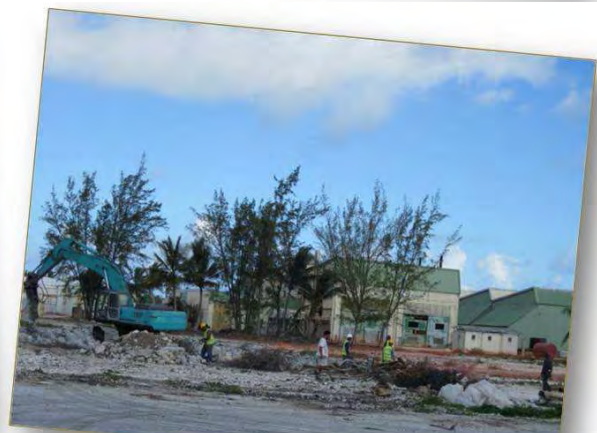
Vue de la zone technique air en cours de chantier
