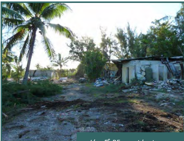
L'ex 5 e RE avant les travaux
