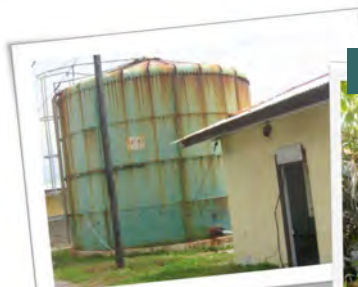
Ancienne citerne d'eau et local annexe
