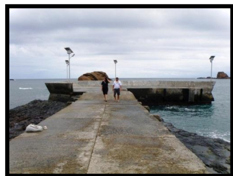
Les fondations du quai ne descendent pas jusqu'au fond (socle solide) mais s'arrêtent au niveau de la mer laissant un espace vide sous celui-ci et transformant cet outil de désenclavement en véritable piège pour les enfants comme pour les adultes.
