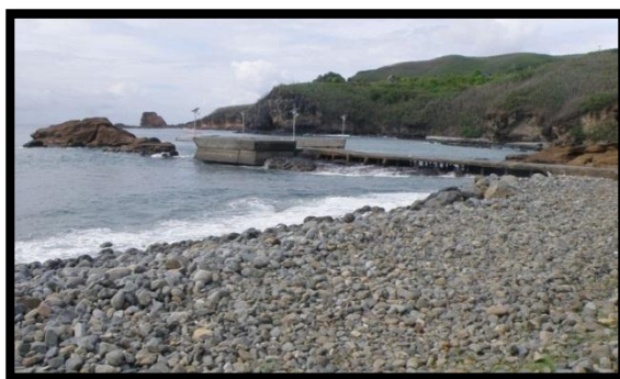
Les fondations du quai ne descendent pas jusqu'au fond (socle solide) mais s'arrêtent au niveau de la mer laissant un espace vide sous celui-ci et transformant cet outil de désenclavement en véritable piège pour les enfants comme pour les adultes.
