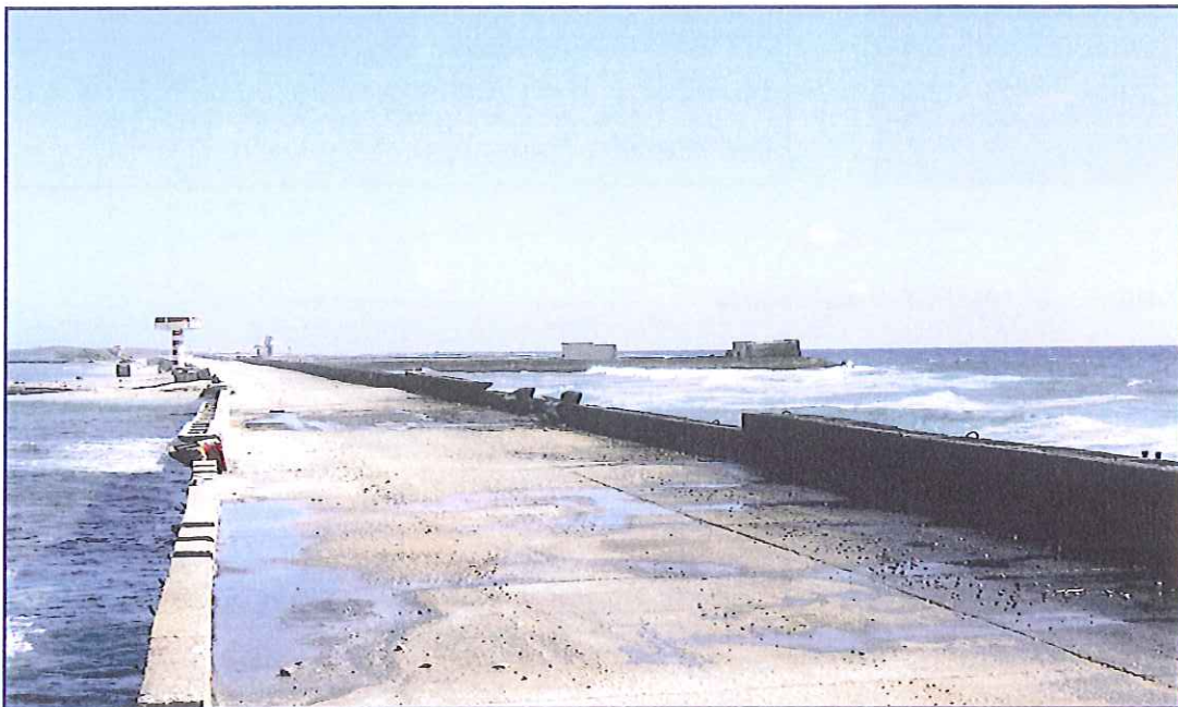
Plateforme refuge sur la route Nord à Mururoa
