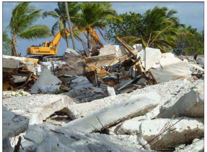
Démolition des bâtiments
